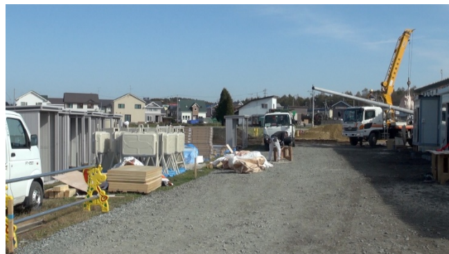
仮設住宅 (早来地区建設風景) 早来 17戸 追分 13戸
