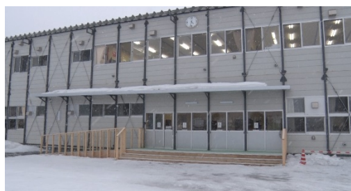
早来中学校仮設校舎
