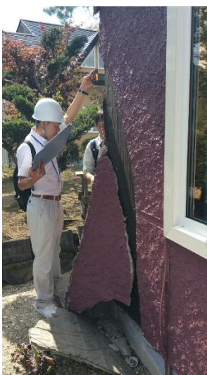
現場調査の様子
