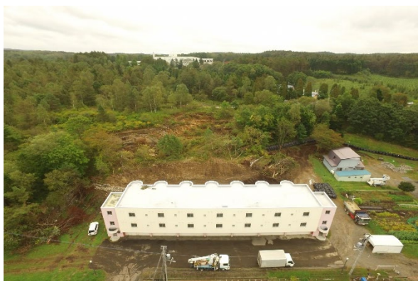
早来北進特定単身者住宅に迫る土砂崩れ
